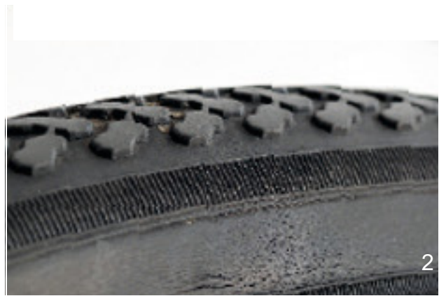
Figura 136: Ejemplos de fisuras por fatiga (1) y fisuras por envejecimiento (2)
