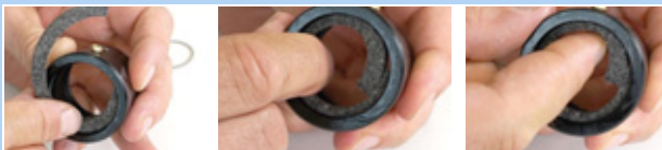
Obr. 240: Vložení plstěného kroužku
